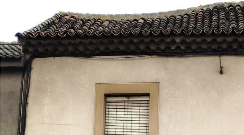
Cubierta deformada por mal estado de la estructura
