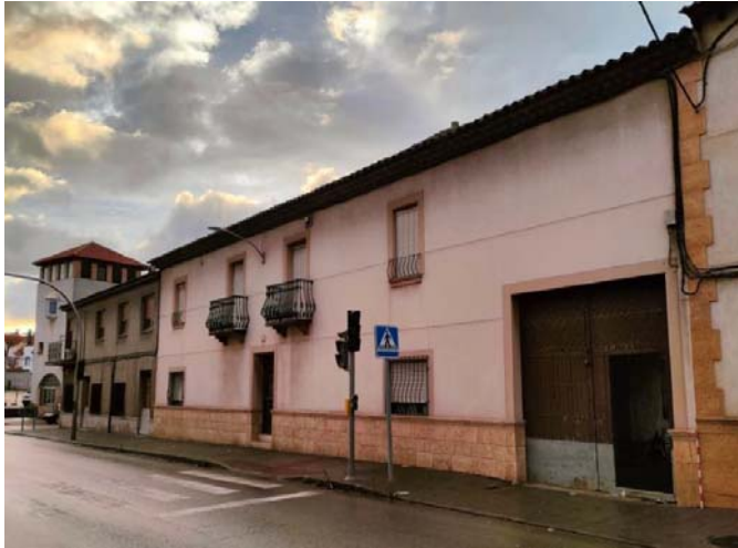
La fachada principal sobre la calle Isaac Peral, originalmente encalada, hoy presenta acabado de mortero monocapa
