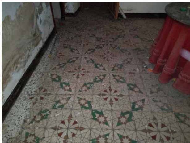
Solado de baldosa hidráulica
