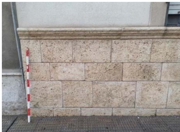
Zócalo revestido de piedra artificial
