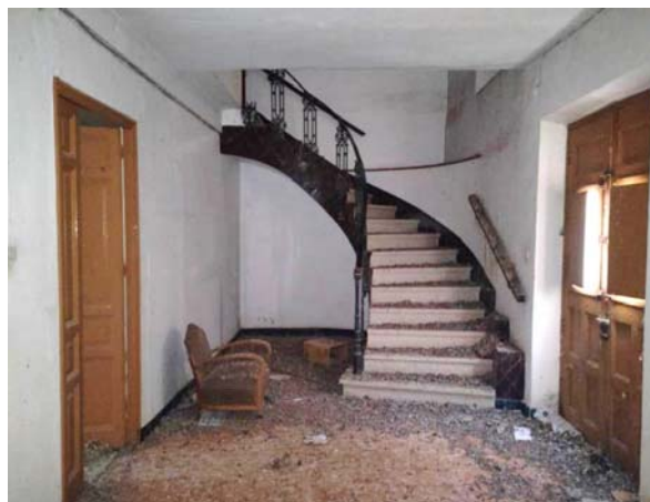
Escalera interior con balastrada de forja
