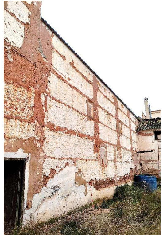
Muros en tapial de tierra con rafas de mampostería caliza
