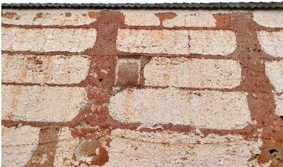
A la izquierda, detalle constructivo del alzado de tapial y alguno de los vanos tapiados
