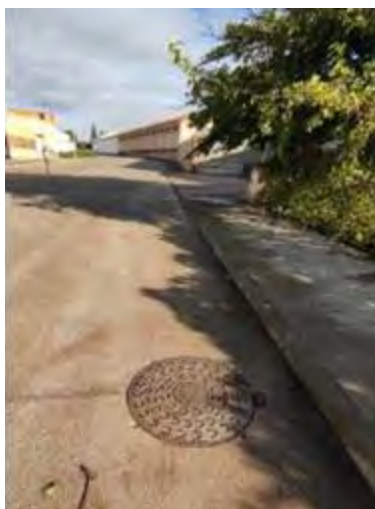
calle Travesía de la Mota acera y calzada pavimentadas
