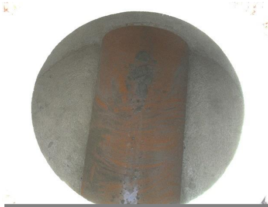
Imagen. Detalle de acabado de fondo de pozo de saneamiento.
