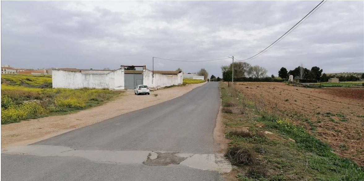
Cercado en estado aceptable en la parte sureste del ámbito Eras de La Agustina.
