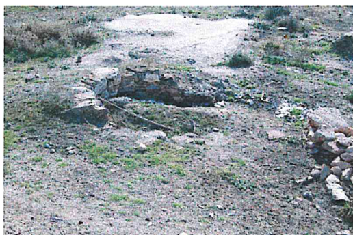
Foto 7. Foto del estado actual del horno.
