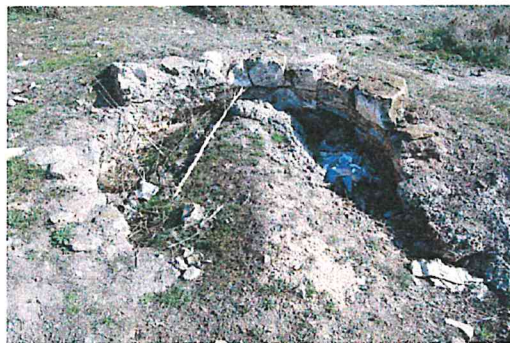
Foto 8. Foto del estado actual del horno.
