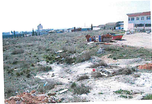
Foto 39. Estado actual de la parcela 189 con los restos de obra.
